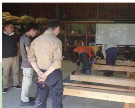
木造建築施工①
